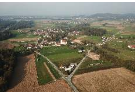
Na Skaručni bomo celovito gradili komunalno in cestno infrastrukturo
