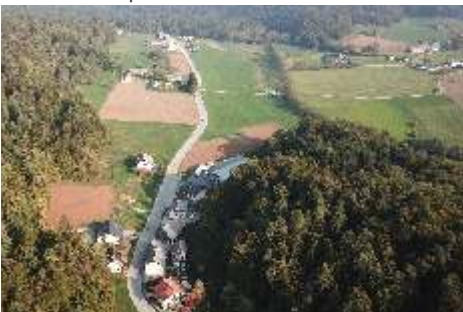
Obnovili smo cesto v Kosezah, dogradili površine za pešce, javno razsvetljavo, optično povezavo in zamenjali azbestne vodovodne cevi
