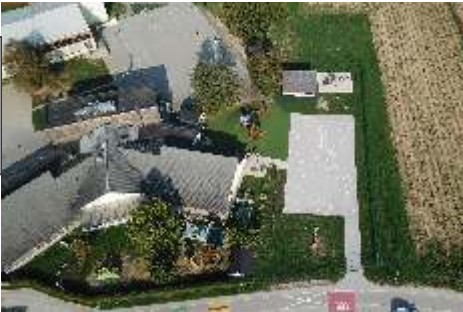
Dogradili in obnovili otroška in športna igrišča v šole
