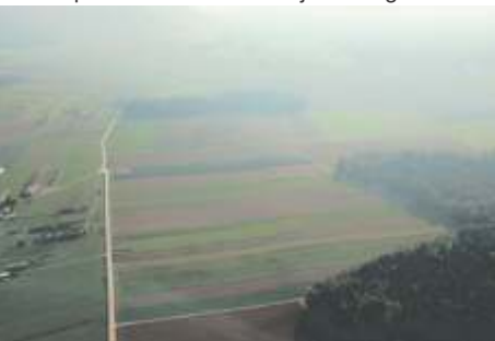
Izvedli smo komasacijo in zgradili preko 10 km novih poljskih poti
