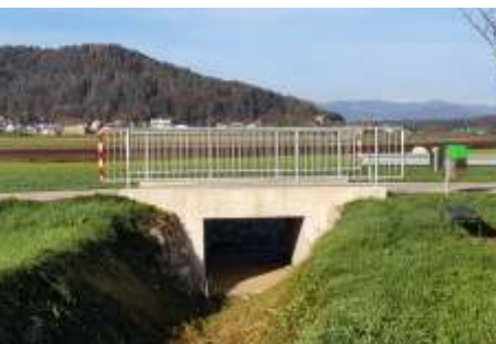
Zmanjšali smo poplavno ogroženost občine, zgradili 9 novih propustov in redno čistili jarke
