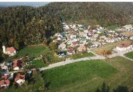
V Utiku na obeh še nepokritih območjih in delu Kosez, delu Bukovice in Vodici, kjer so že pridobljena gradbena dovoljenja bomo zgradili novo fekalno kanalizacijo, vodovod, javno razsvetljavo in obnovili ceste
