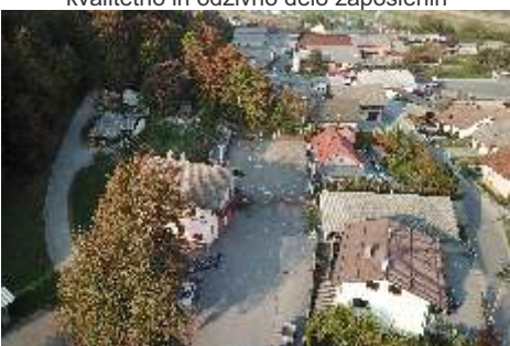
V Repnjah smo zgradili novo športno in otroško igrišče ter asfaltili makadamski cesti proti vodohtoru in Sv.Tilnu
