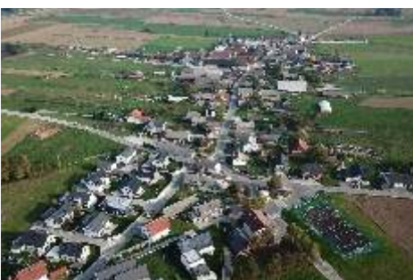
V Polju smo celovito obnovili komunalno in cestno ter otroško in športno infrastrukturo
