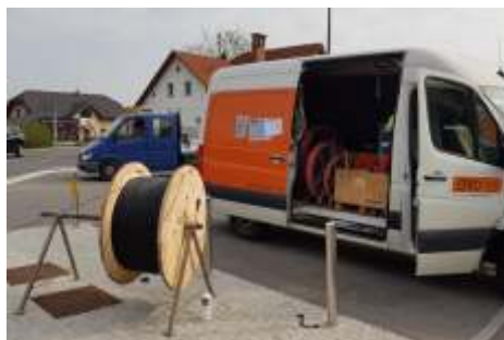
Prizadevali si bomo za pokritost celotne občine z optičnem in zmogljivim električnim omrežjem
