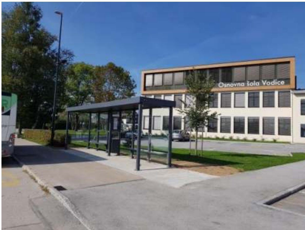
Foto: Stare lesene avtobusne nadstrešnice postopoma zamenjujemo s sodobnejšimi, varnejšimi in manj vpadljivimi avtobusnimi postajališči
