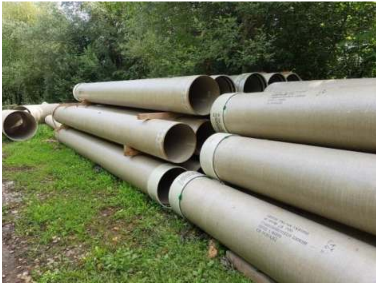
Foto: Največji okoljski projekt v občini Vodice bo v začetku omogočil priklop na javno kanalizacijo kar 2.600 občanom, naknadno ob zagotovitvi finančnih virov pa bo mogoče priklope izvesti skoraj v vseh naseljih
