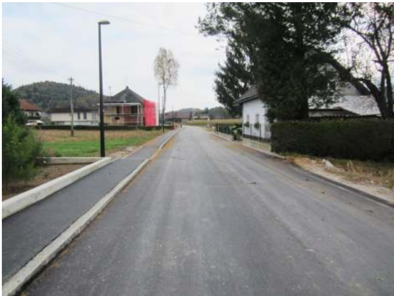
Foto: V sklopu projekta C0 in sočasne gradnje skrbimo za celovito obnovo komunalne infrastrukture v naseljih Utik, Bukovica pri Vodicah, Polje pri Vodicah in Povodje
